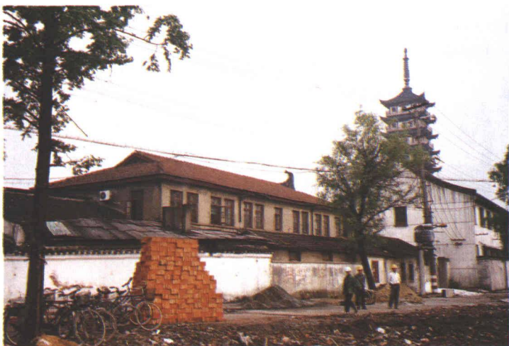
长征联合医院住院部旧址(用洋瓦所盖房屋)
