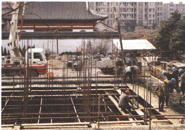
真如佛塔施工工地
