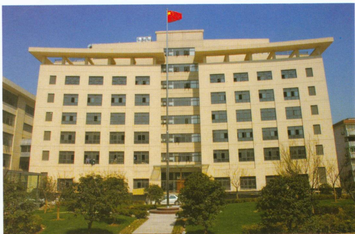
真如镇人民政府办公大楼全景
