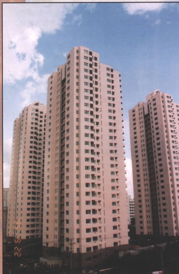
已竣工的3栋28层住宅楼
