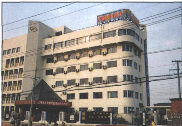
已竣工的普陀区规则土地局大楼
