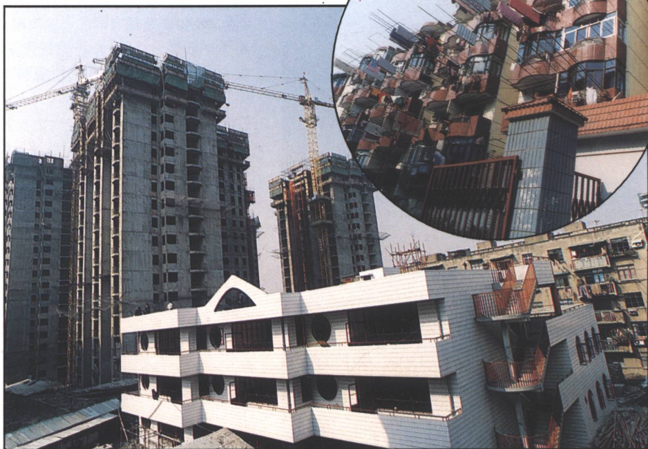
在建的天成小区(高层)和即将竣工的甘泉一村幼儿园
