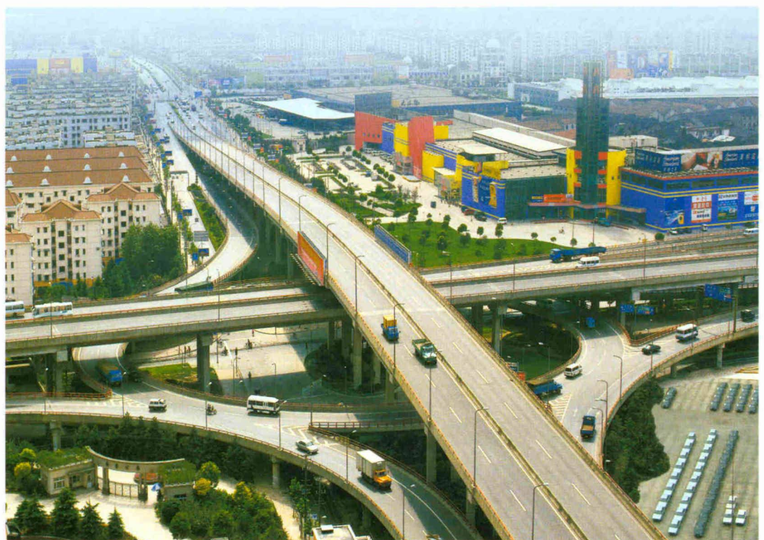
真北路立交桥 Zhenbei Road Flyover
