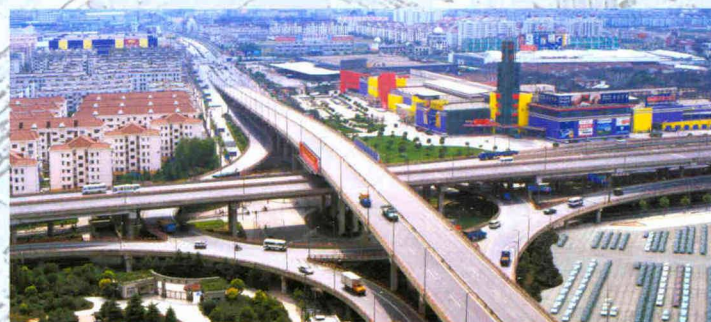
真北路立交桥 Zhenbei Road Flyover
