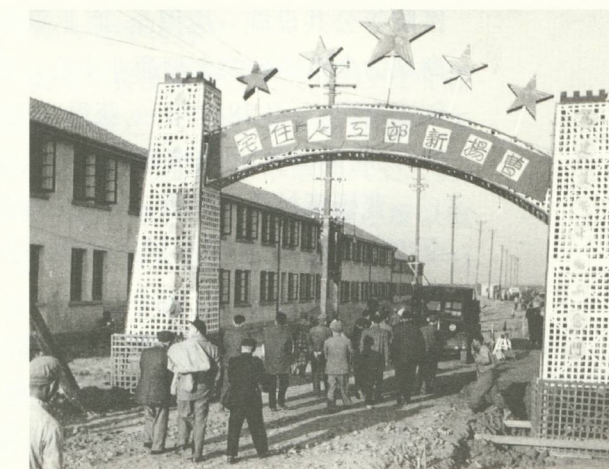
1952年上海市两万户工人住宅开工大会照片——图为曹杨新村建成后参观的人络绎不绝
