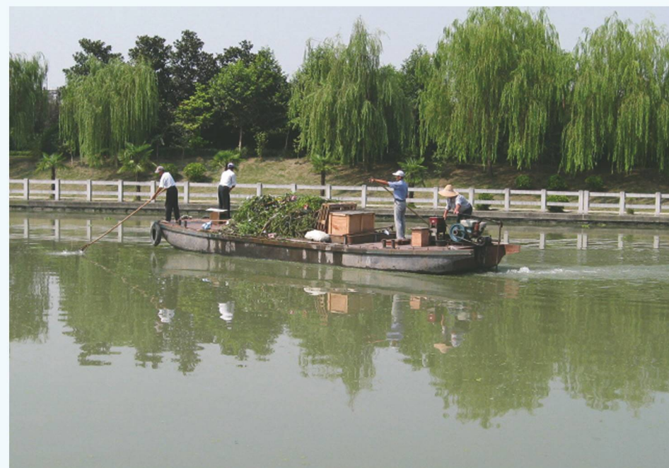
整治疏浚河道
