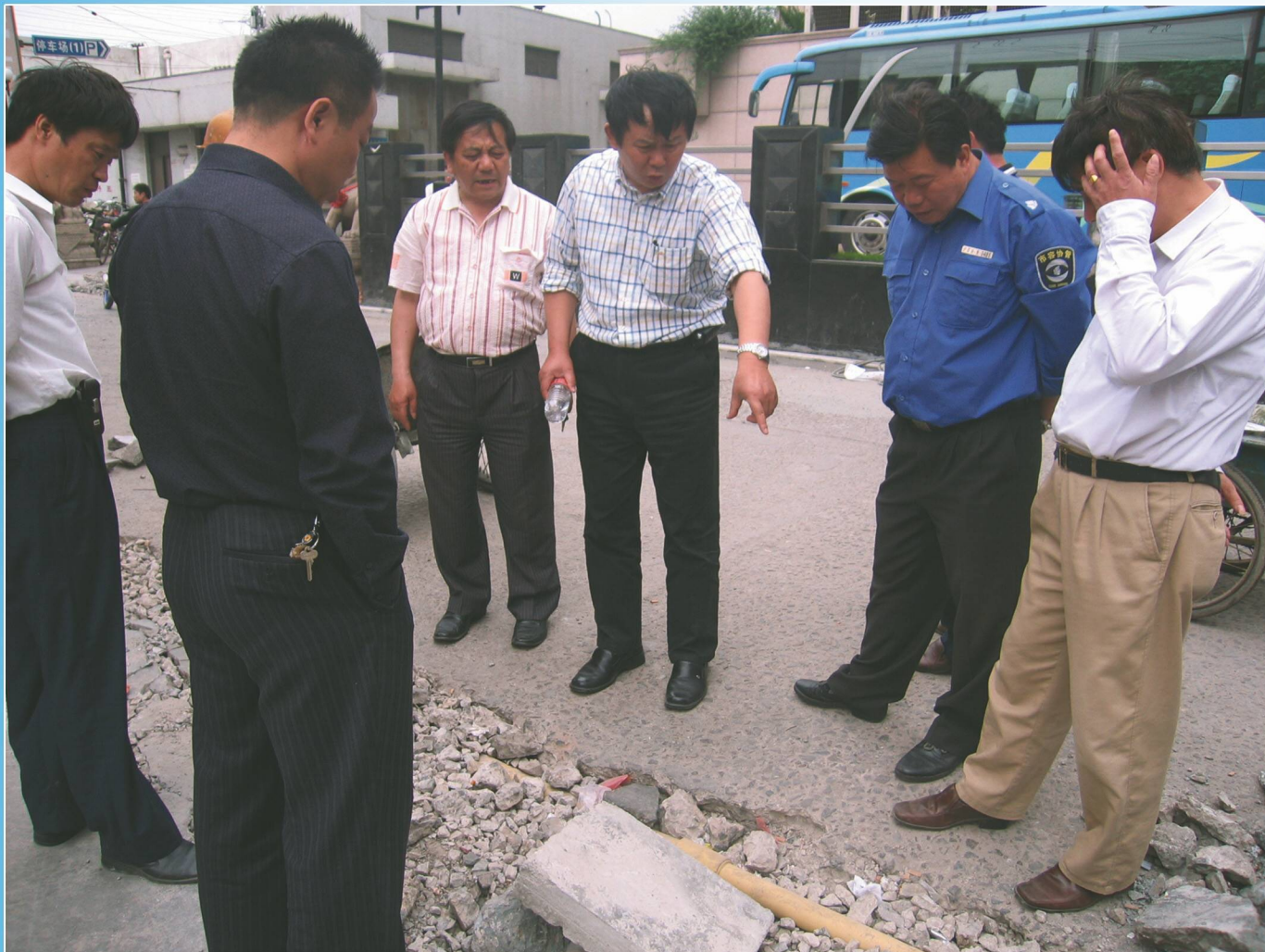
调研道路改建工程
