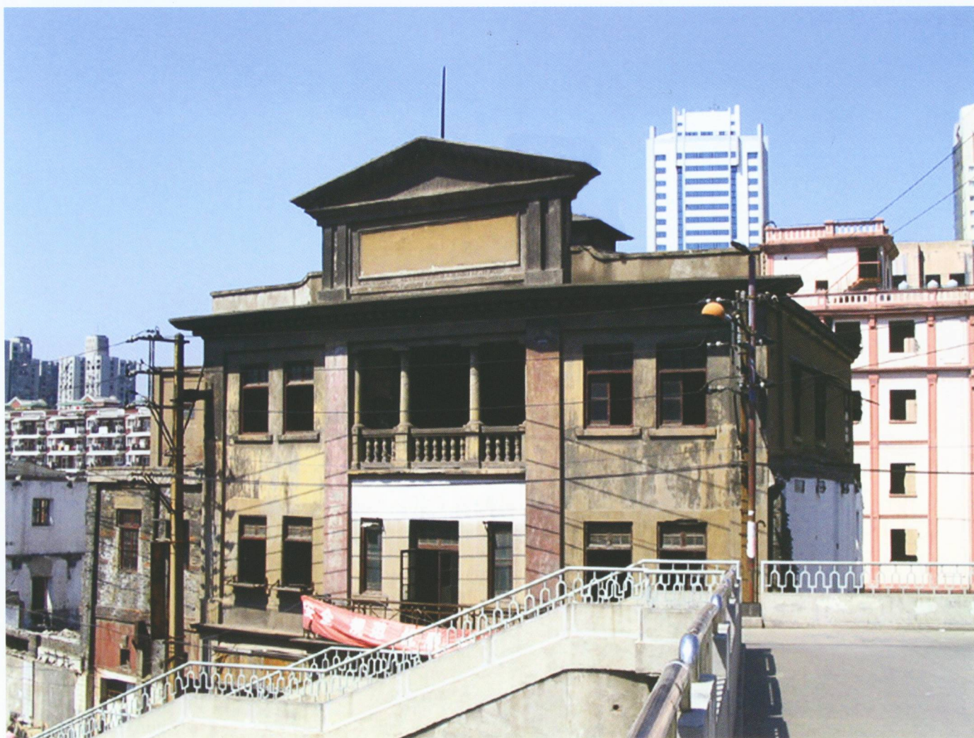
西康路桥堍的福新第三面粉厂旧址
