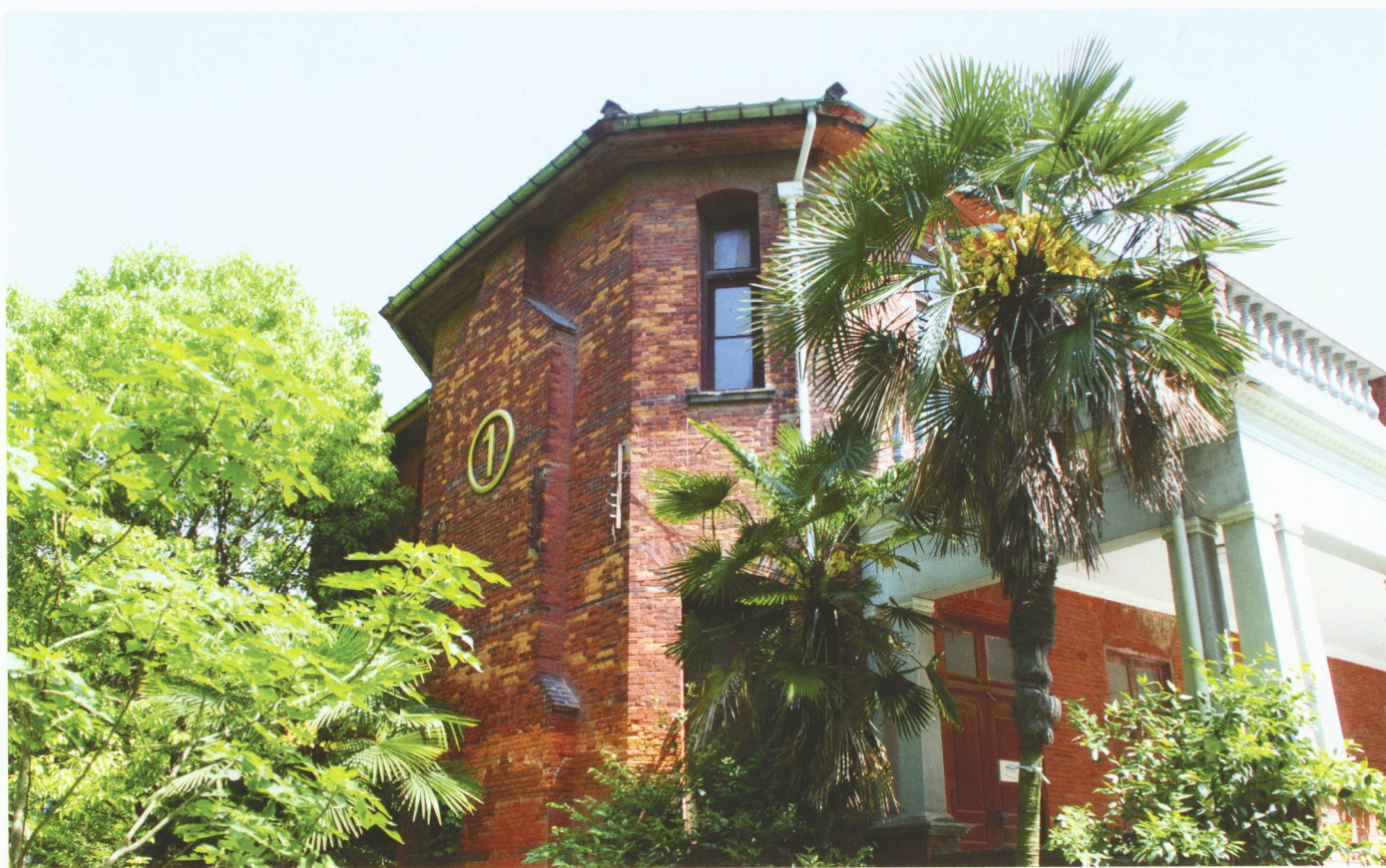
上图：办公楼主立面
