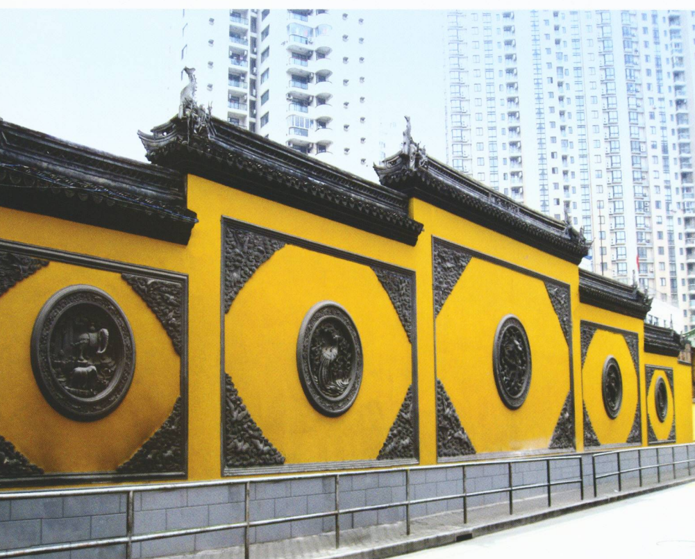
修缮后的照壁
