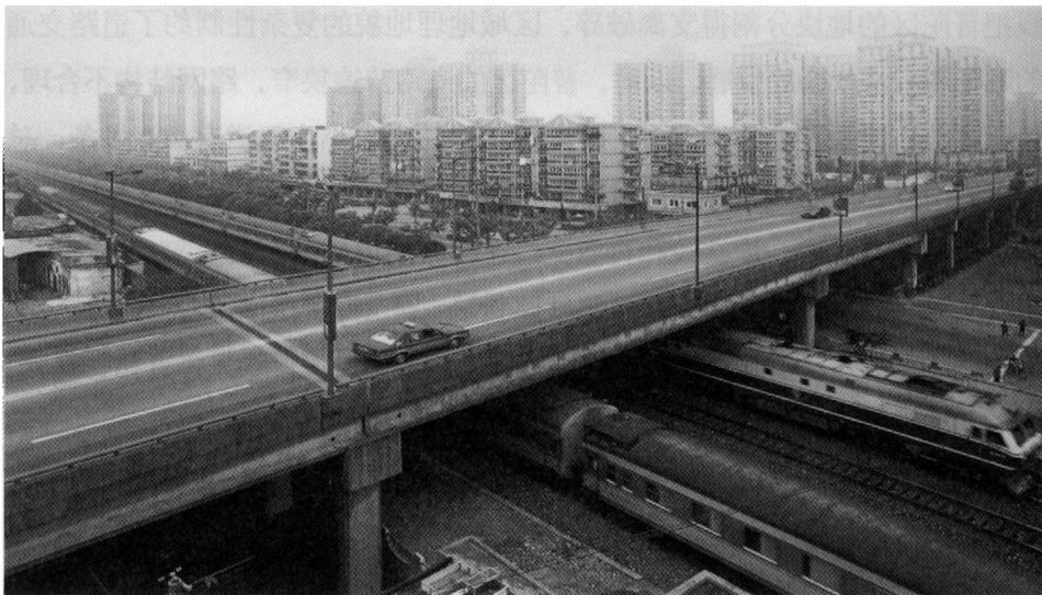
1994 年，光新路铁路立交桥工程在普陀区光新路石泉路至甘泉路建成通车 \
