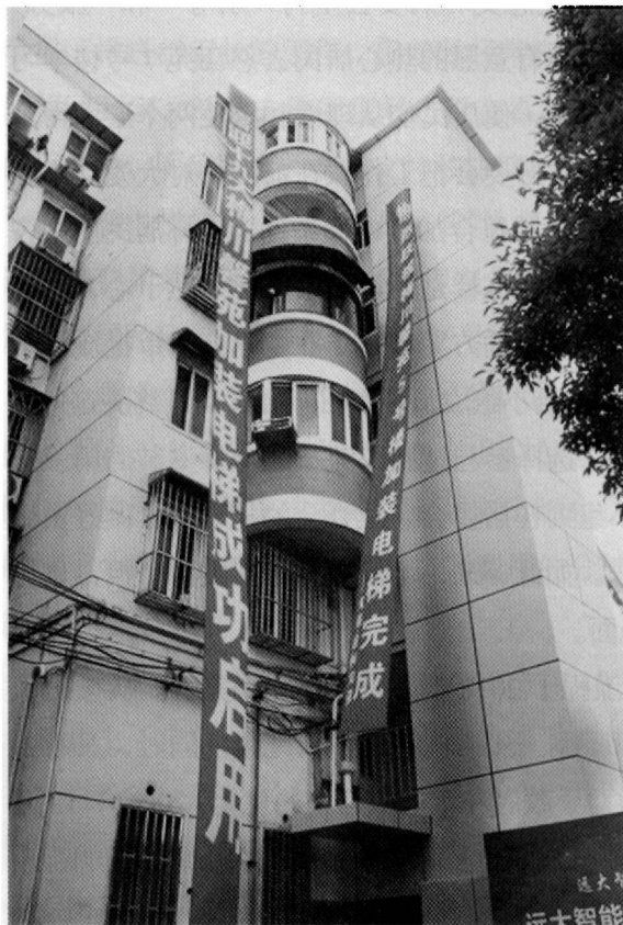
▲ 2017年10月30日，梅川馨苑5号楼加装电梯工程竣工
