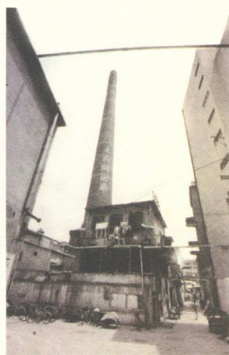
上海酵母厂解放后厂房一景
