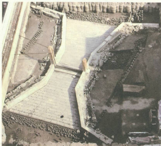
志丹苑工程发现的元代水闸遗址
