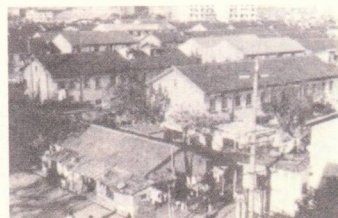
纺织系统联建的棉纺新村旧貌
