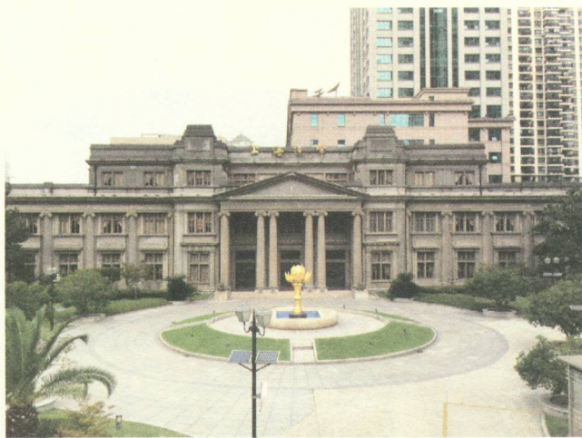
上海造币厂旧大楼现状
